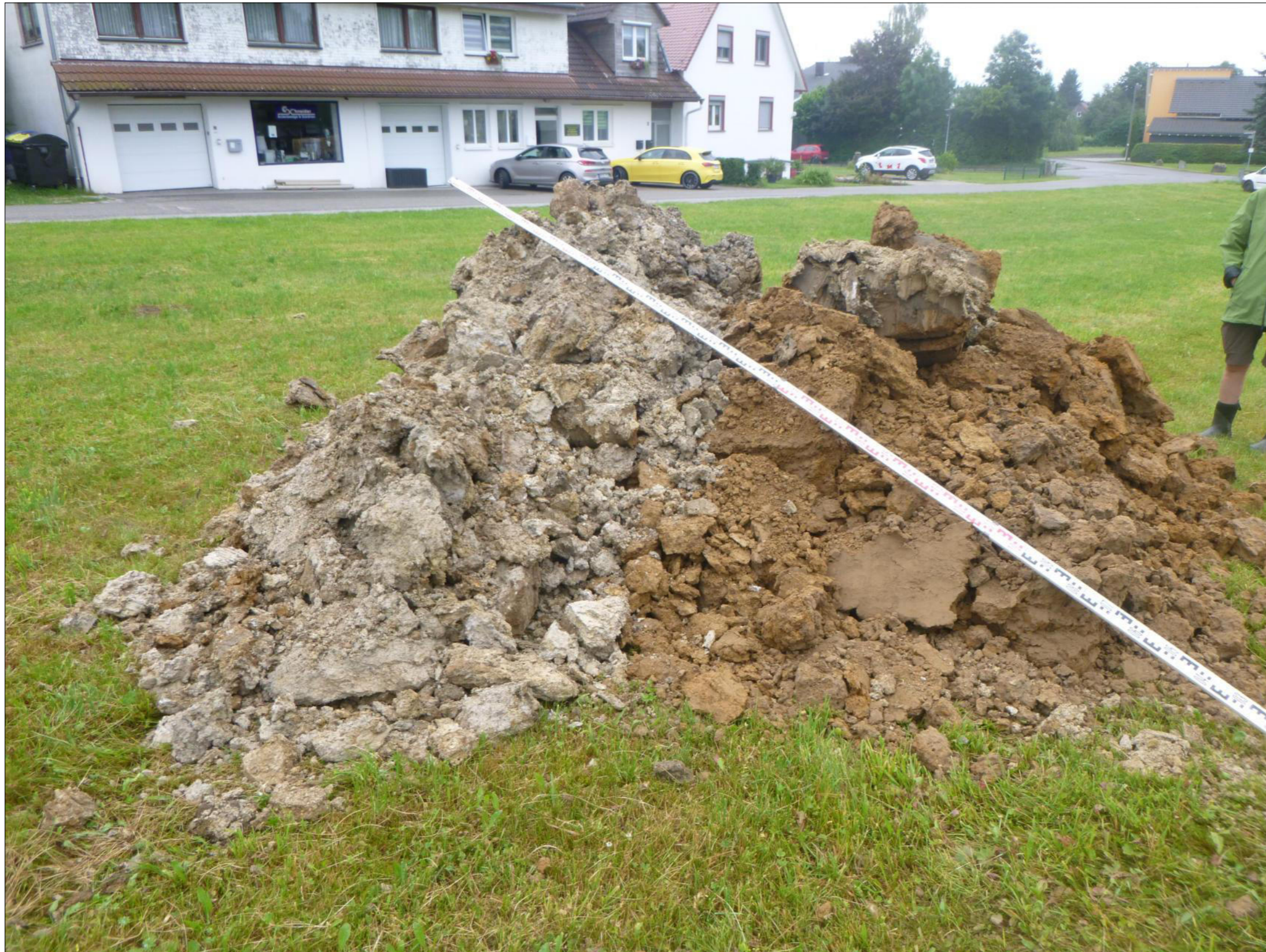
Bild 5: Blick auf Erdaushub Schurf 3
