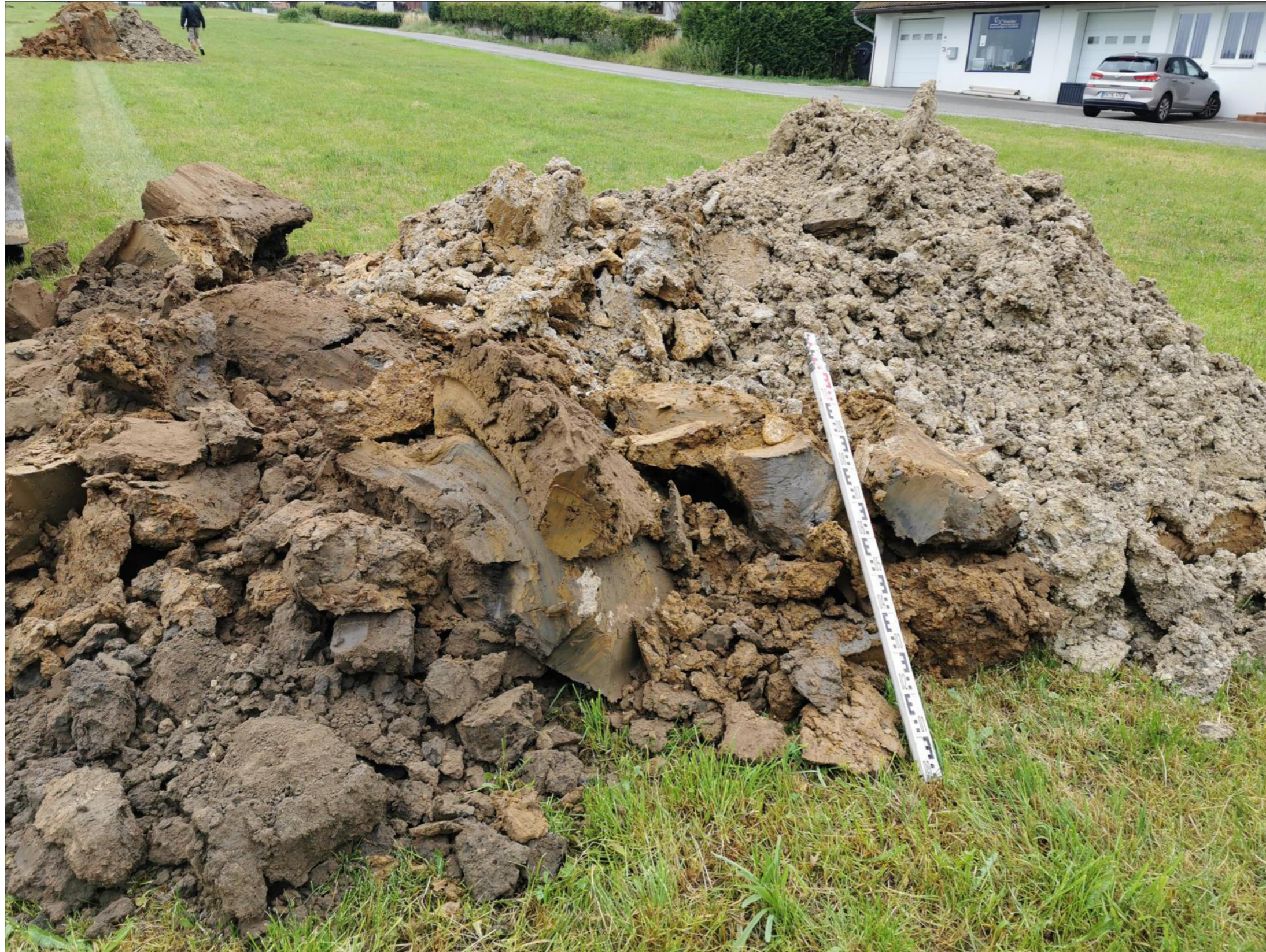
Bild 7: Blick auf Erdaushub Schurf 4
